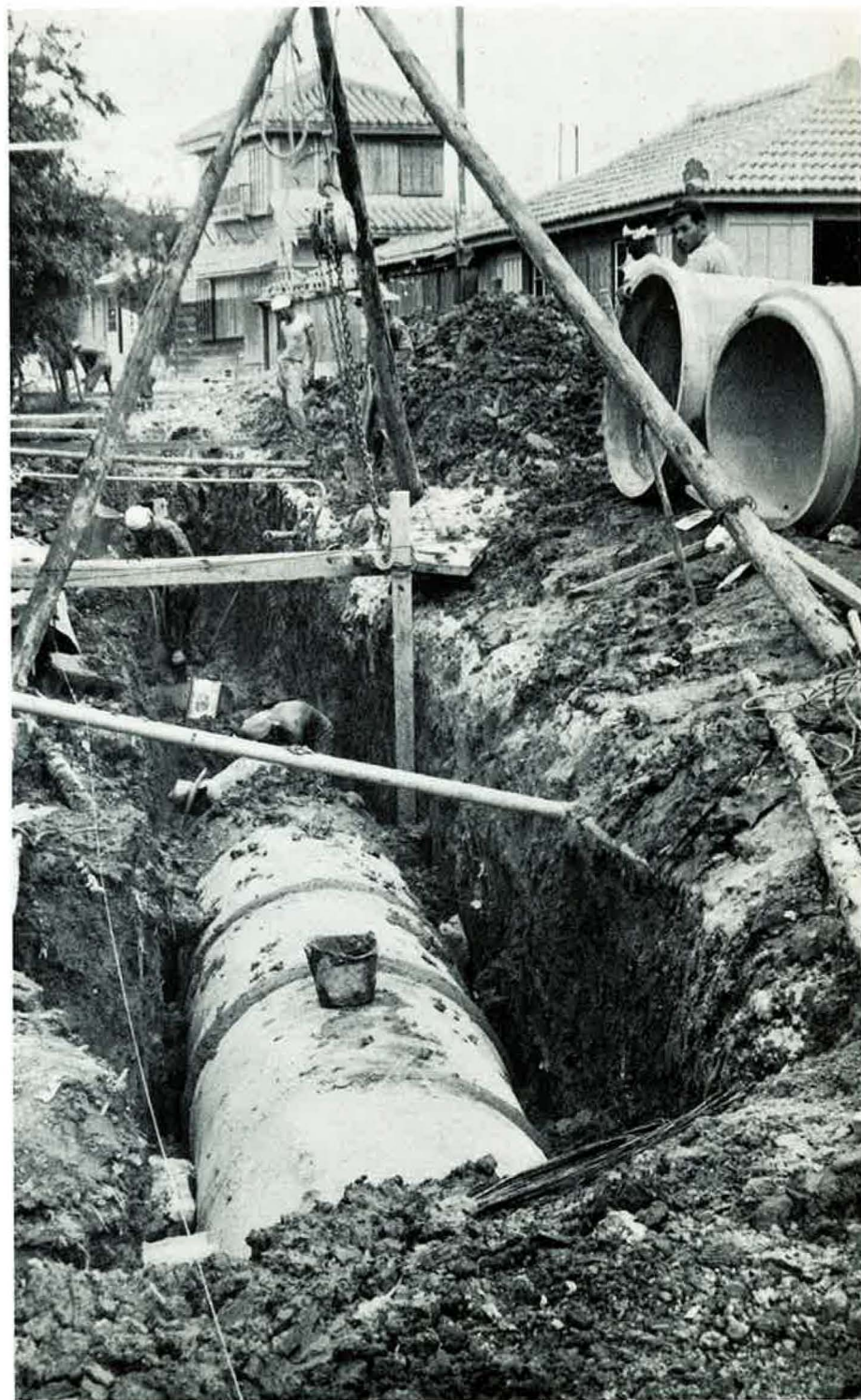
■ 排水管敷設工事
